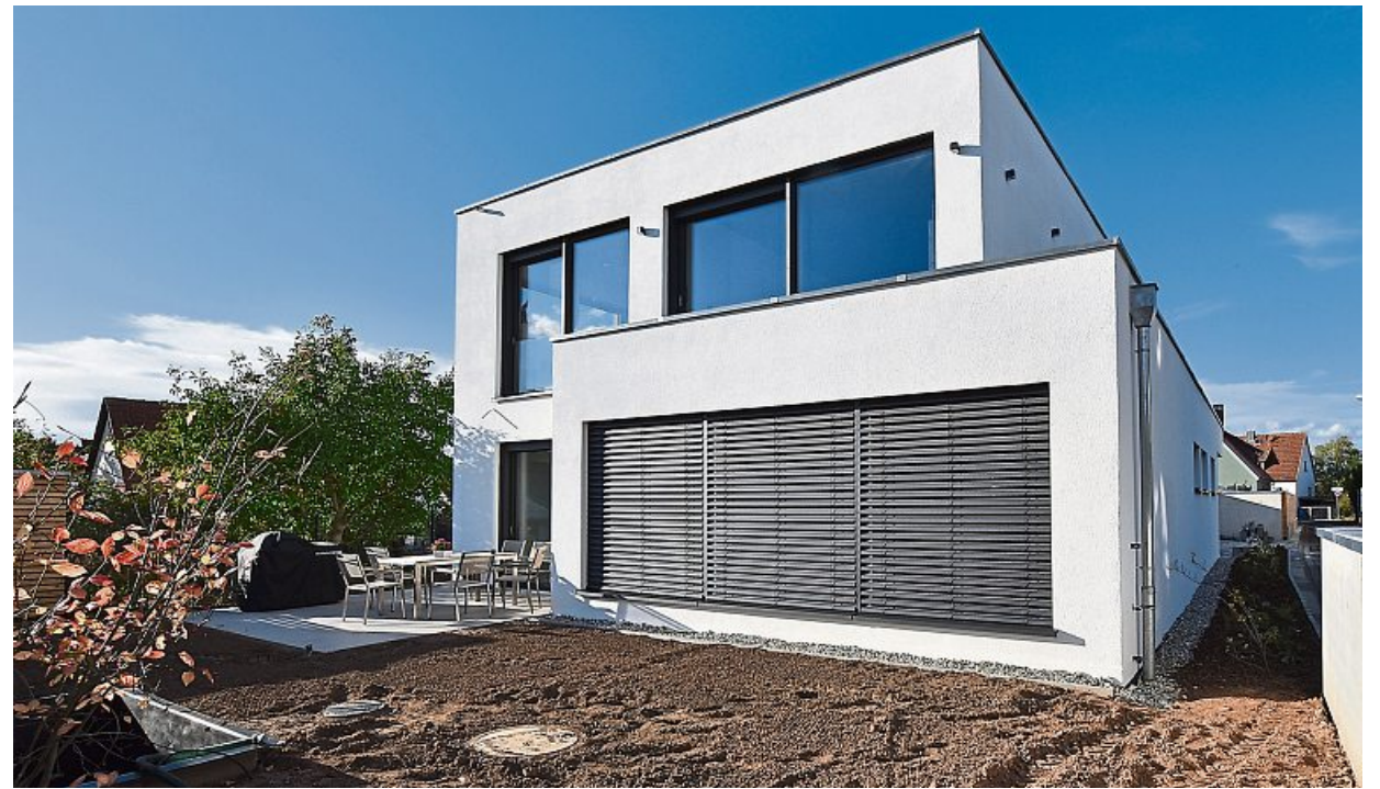
Bei den Führungen durchs Haus lernen Besucher einen speziellen Mix aus Öko-Hightech-Komponenten kennen, um Energie aus regenerativen Quellen optimal zu nutzen. FOTOS: RAUMKLIMASYSTEME
