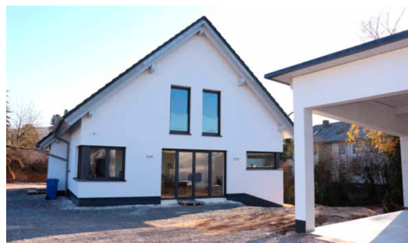
Das Grundstück haben die beiden von Lorenz' Familie erhalten. Förderungen der KfW und des Freistaats haben es möglich gemacht: ein Haus nach bestem Standard.
