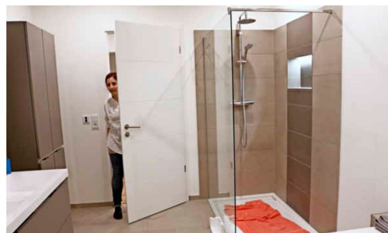
Der Innenausbau im Erdgeschoss ist abgeschlossen. Im oberen Geschoss wartet noch einiges an Arbeit auf die jungen Bauherren.
