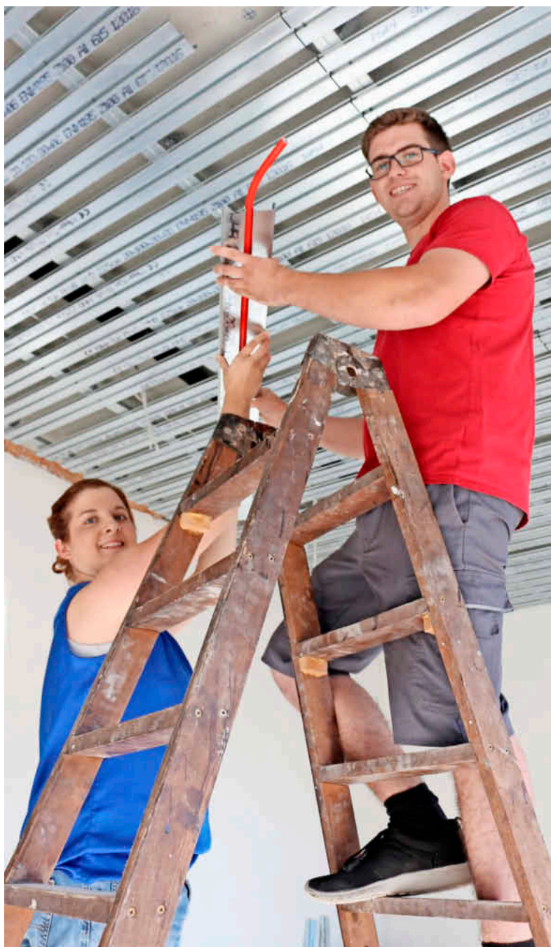
Sparen durch Eigenleistung: Die Schienen für ihre Deckenheizung haben Karolina Lorenz und Simon Franz selbst angebracht.
