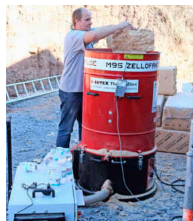
Steffen Volk von der Firma Gutex füllt die Holzfaser für die Einblasdämmung ein.
