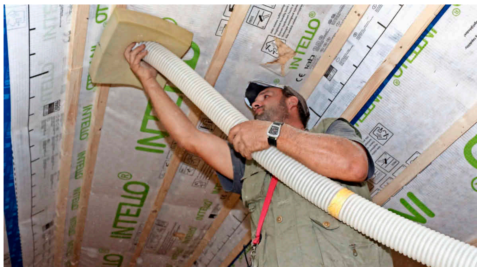
Martin Wunderlich von der Firma Keidel aus Birkenfeld bei der Arbeit. Die Einblasdämmung war für ihn bisher Neuland. Nach einer Einweisung am Vormittag ging es am Nachmittag im Niedrigstenergiehaus im Marktheidenfelder Lohgraben ans Werk. Foto: Christian Weyer
