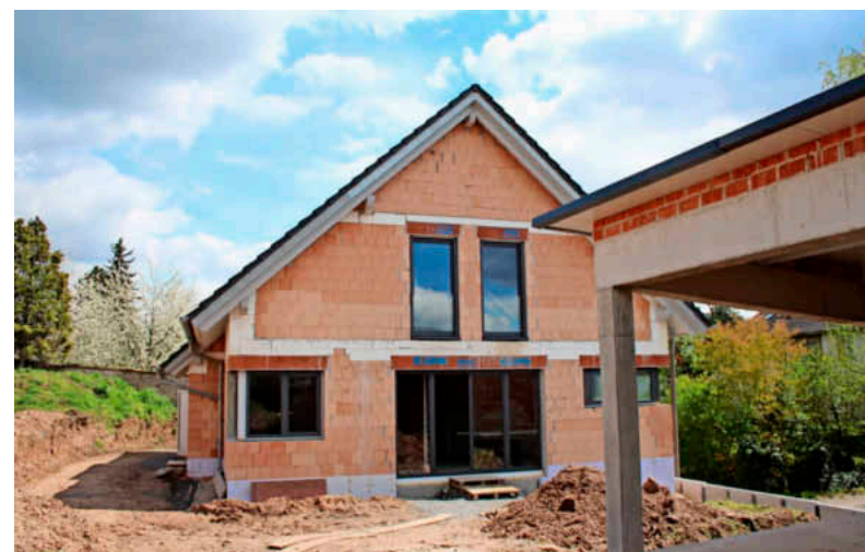
Der Rohbau steht: Nach einer winterlichen Zwangspause gehen die Bauarbeiten seit April weiter.
